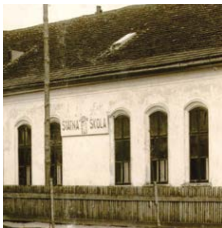
Nápis na ľudovej škole so stĺpom telefónneho vedenia
