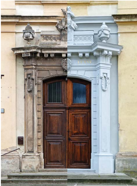
Kláštor baziliky, vchod hlavný portál starý a vpravo po rekonštrukcii
